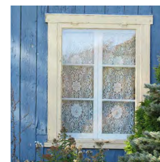
Fenêtres avec moulures
