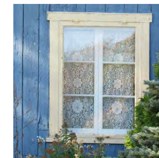
Fenêtres avec moulures
