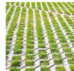
Pavé alvéolé en béton
