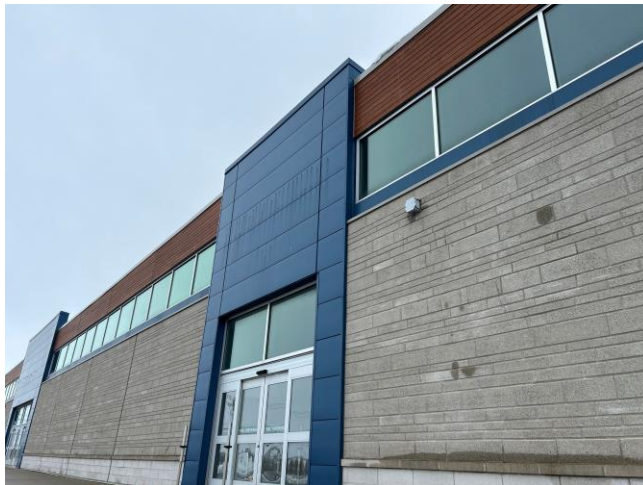
Centre sportif intérieur
